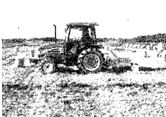
籾殻充填暗渠施工作業
