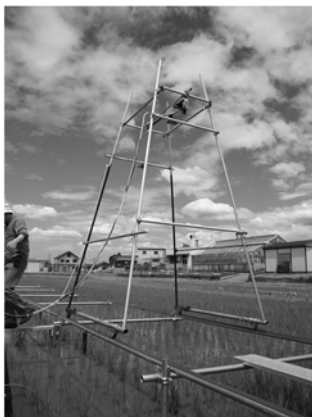
写真 1 センター内での計測
