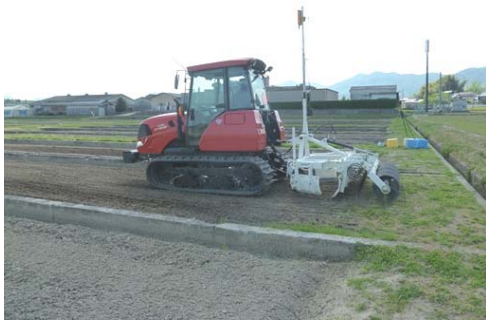
写真1 レーザーレベラーでの施工状況 フルクローラトラクタでの直装式レベラー(勾配機能無)
