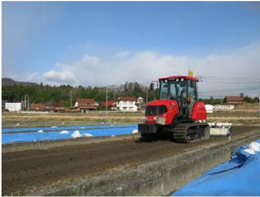
写真1 レーザーレベルによる傾斜施工
