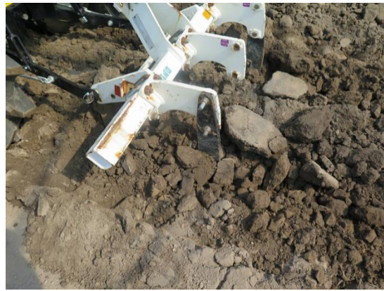
写真2 プラソイラ施工後の土壌
