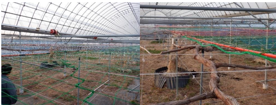
新梢管理装置設置
