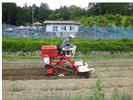
埋め戻し作業（実証区）
